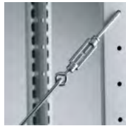
Diagonale schoor met spanslot
