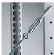
Diagonale schoor met spanslot
